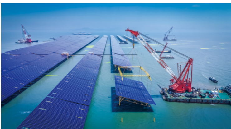
中电建海上光伏项目吊装现场。孙毅 摄
