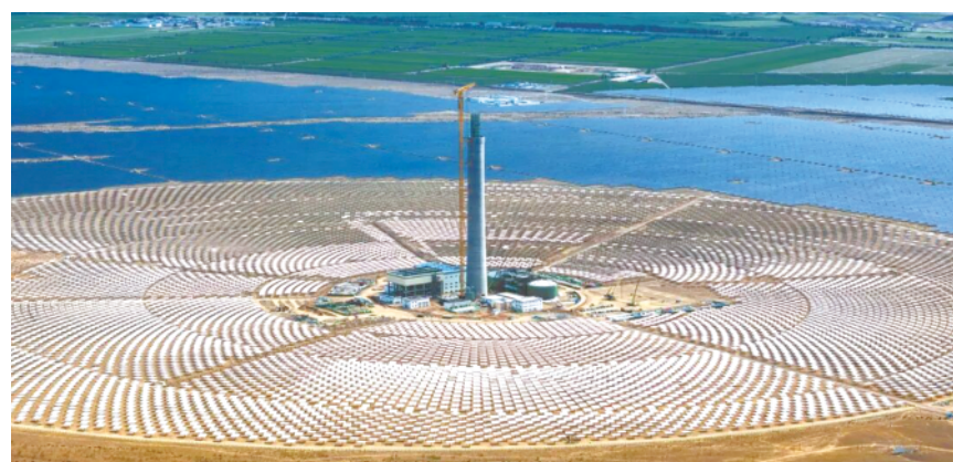
位于新疆博尔塔拉蒙古自治州的10万千瓦储热型光热配建90万千瓦新能源项目。
