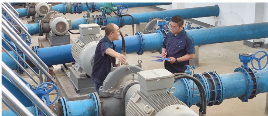
水厂工作人员检修水泵。
