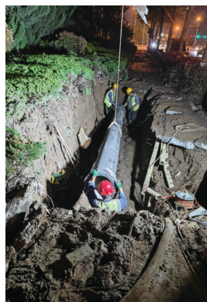
工作人员连夜维修供水主管道。
