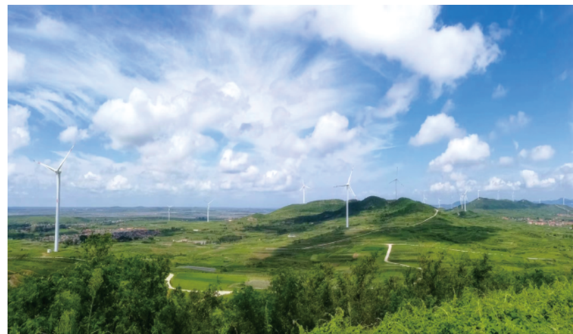
田横镇风力发电项目。
