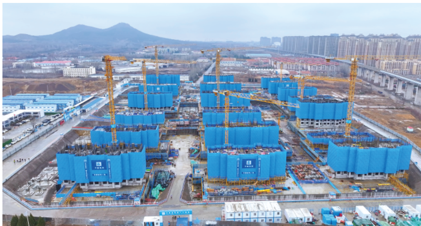
马山新区(下泊片区)改造项目。
