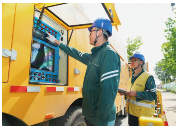
省内首次应用3000千瓦中压发电车助力不停电检修。
