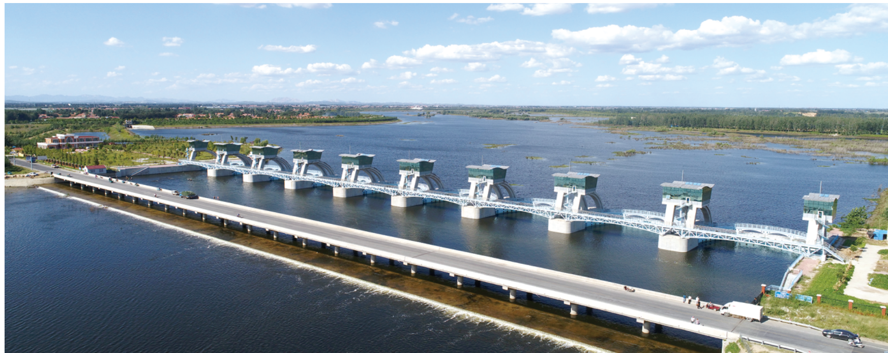
亚洲最大的护镜式拦河闸—移风九孔闸。
