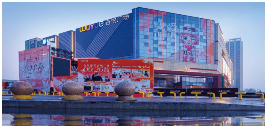
即墨吾悦广场项目9月26日开门纳客。
