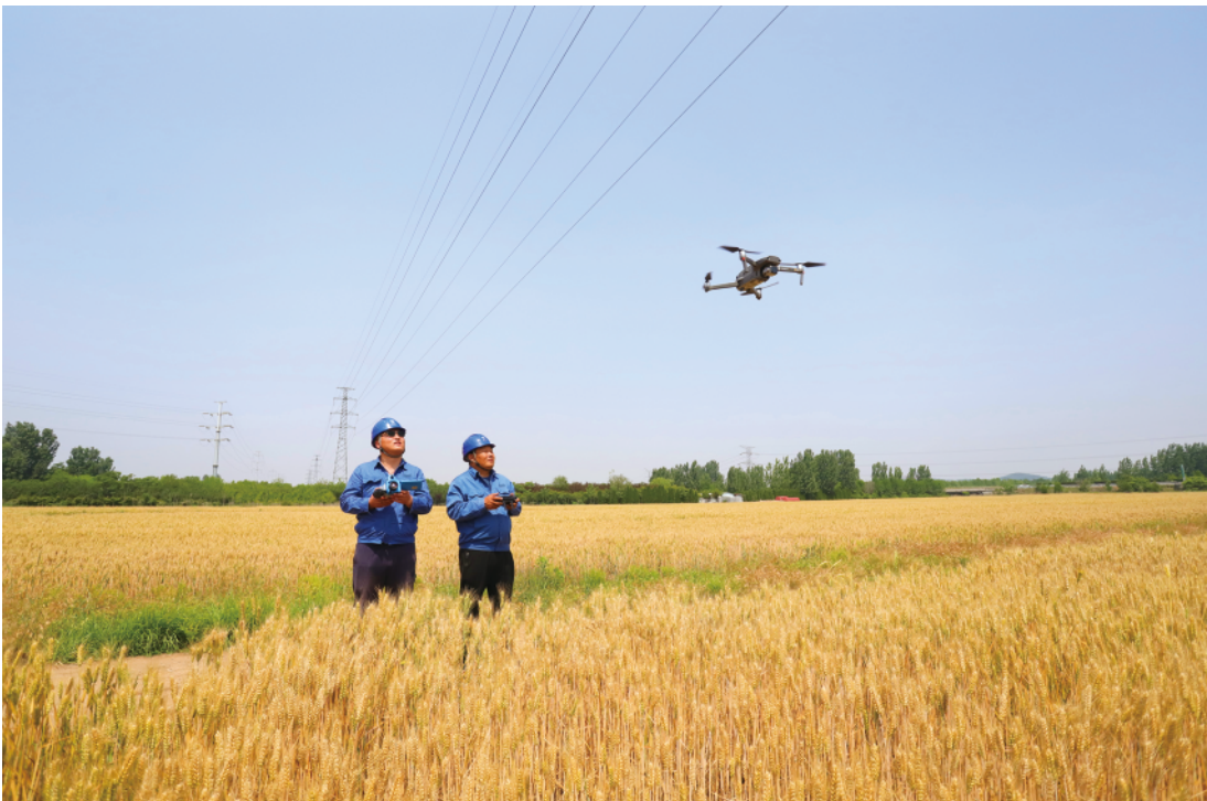
国网青岛市即墨区供电公司输配电运检中心的飞手使用无人机巡视110千伏即玉甲线。
