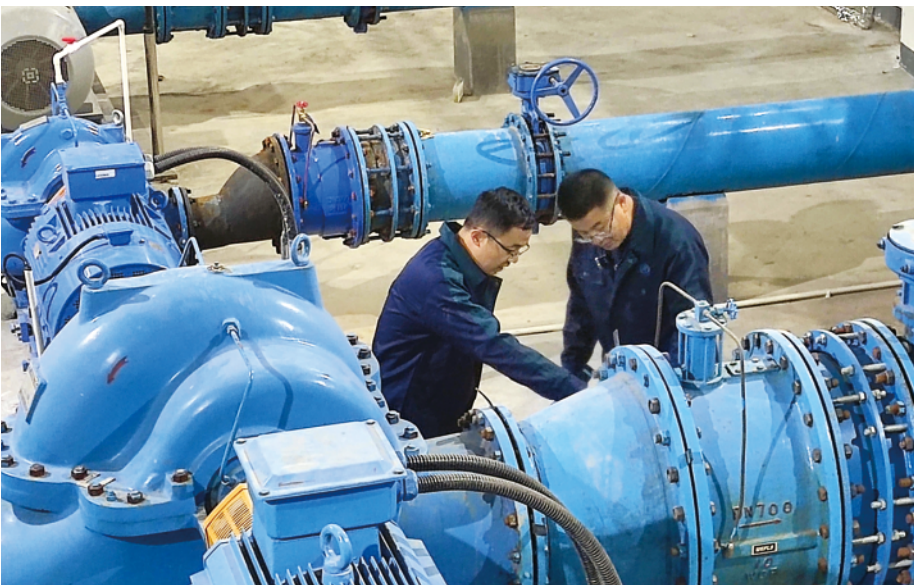
水厂工作人员对水泵保养维修。
