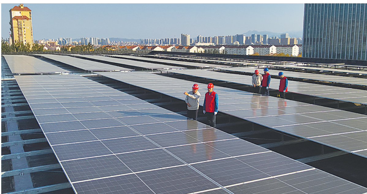
“电博士”协助产业园区检查屋顶光伏并网发电情况。
