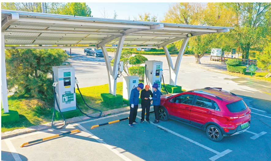
“电小二”为客户讲解光储充放一体化充电桩使用注意事项。
