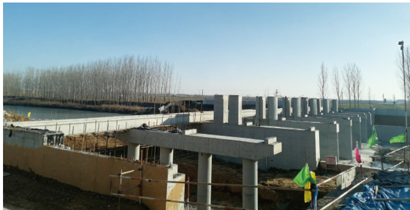
移风店镇水闸除险加固工程。
