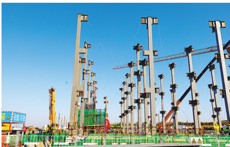
建设中的金岭科技中心项目。
