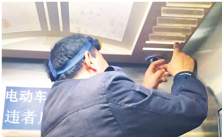
物业人员对电梯内电动车智能阻止系统进行调试。
