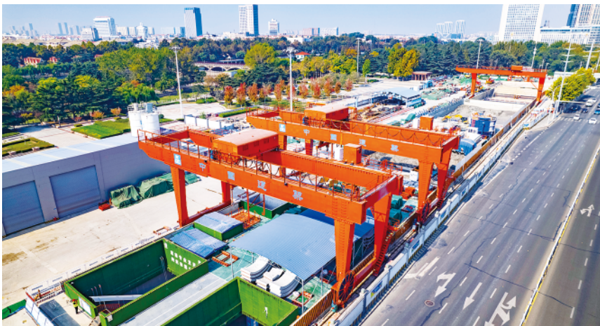
建设中的青岛地铁即墨文峰路站。曲波 摄
