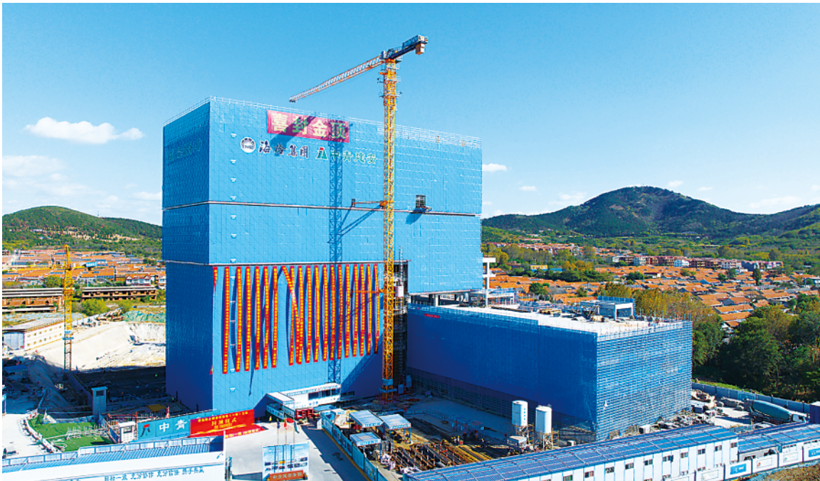
建设中的青岛海上综合试验场(一期)项目。
