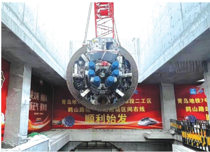
瓦，总推力4086吨，设计最大推进速度达80毫米每分钟。“同舟7号”通过“盾构云”统一各系统数据接口，将所有数据上传至云端，具备“出渣口气体检测”“盾尾间隙自动测量”
