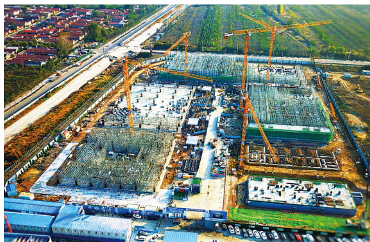
项目施工现场。
