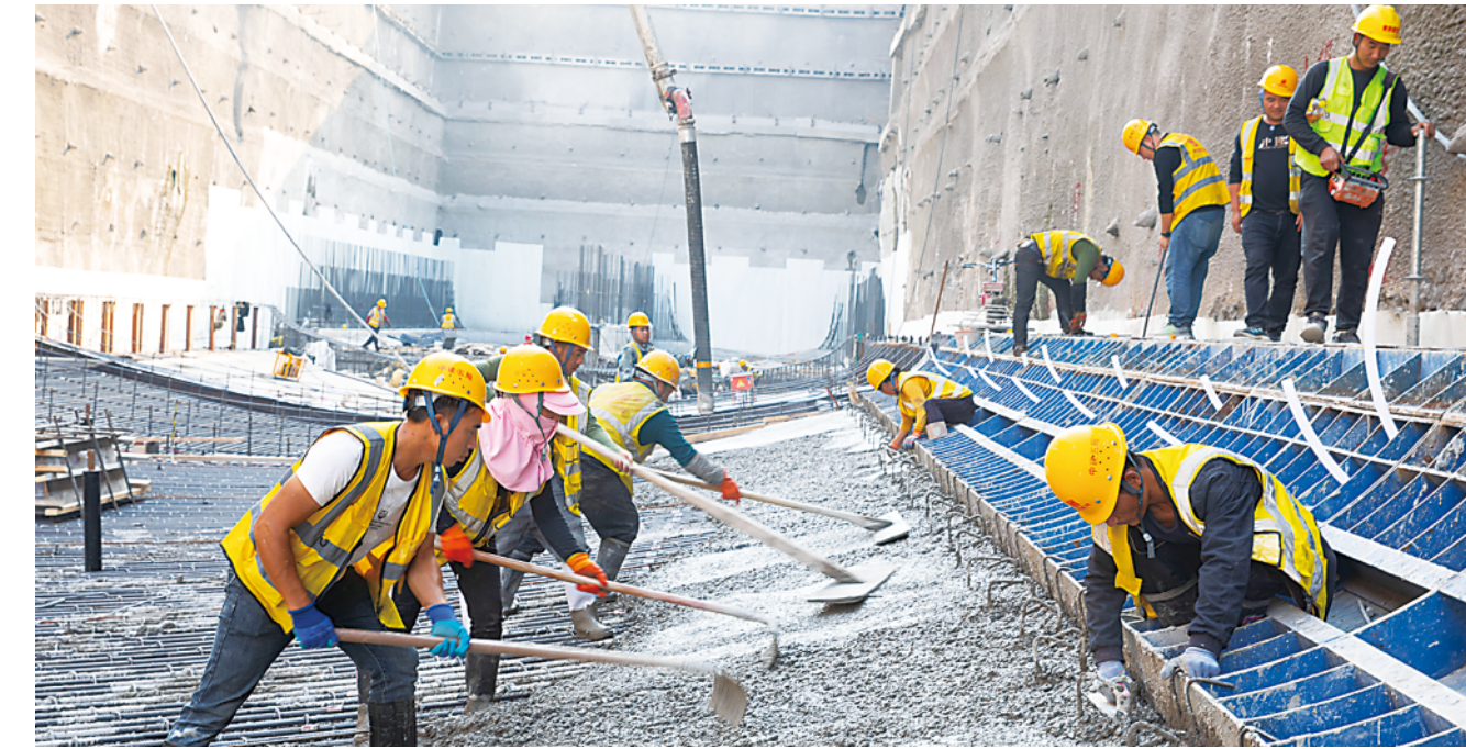
青岛地铁7号线营普路站施工人员进行现浇底板混凝土浇筑。(姜雪 摄)
