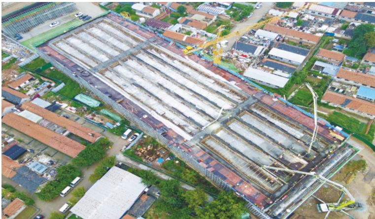
图为公益性项目施工现场。
