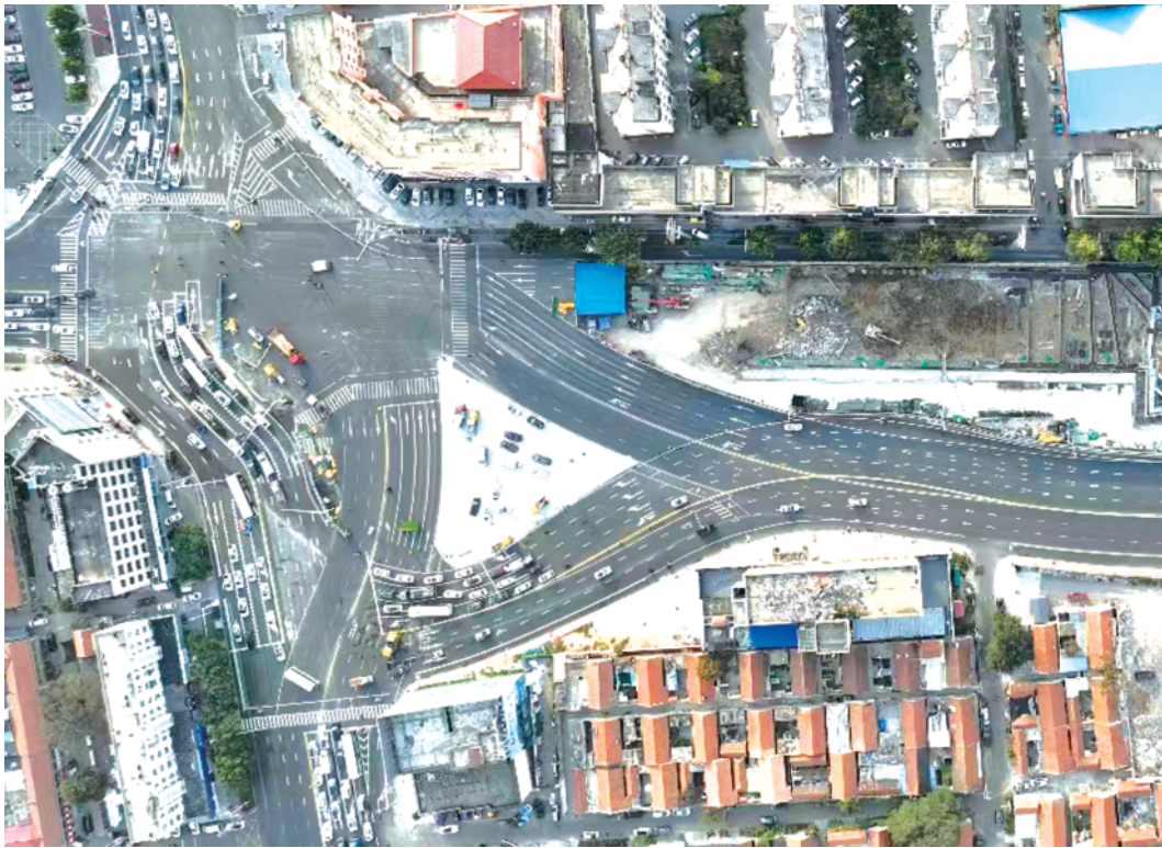
10月8日，青岛市地铁7号线二期工程鹤山路站三期道路完成调流，车站建设进入全面施工阶段。至此，鹤山路站圆满完成全部交通导改任务，车站建设跑出“加速度”。 (刘元平)
