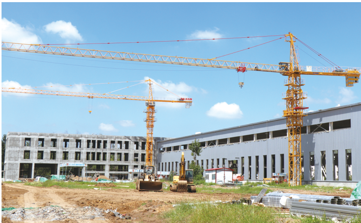
青岛信台金汽车零部件项目施工现场。
